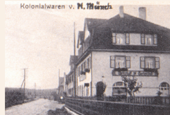
Infrastruktur um die «Gartenstadt», um 1930 Entlang der Rielasinger Straße gab es schon einige Gebäude der Gründerzeit. Hier etablierte sich die erste Infrastruktur wie eine Wirtschaft und Metzgerei.
