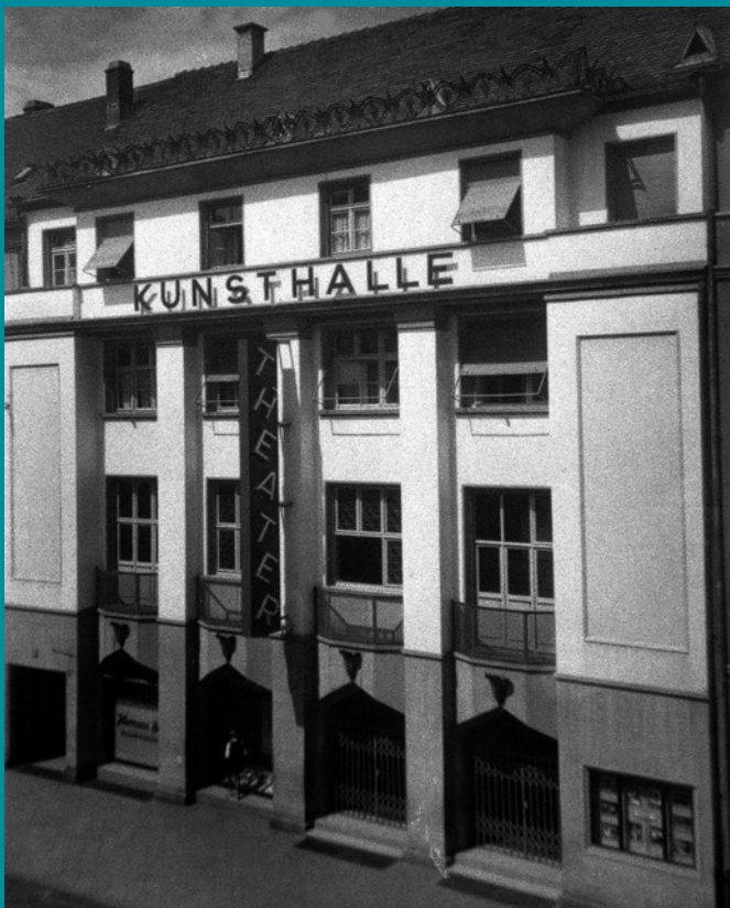
Kunsthalle, Singen 1927/28 Für das damals hochmoderne Medium «Film» wurde 1927/28 die Kunsthalle in Singen errichtet, im ebenso modernen Stil der Neuen Sachlichkeit. Mit Unterstützung der Stadt wurde das Haus ab 1928 auch als Theater genutzt.
