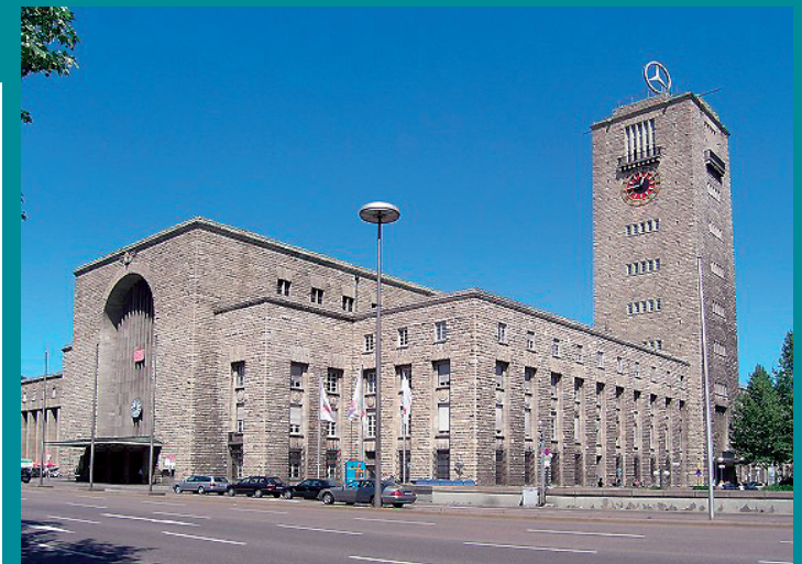
Stuttgarter Hauptbahnhof, erbaut 1914–1928 Herausragendes Beispiel des Monumentalismus in Deutschland vor der Epoche des Nationalsozialismus. Als Gegenbewegung zur Moderne war dieser Stil aber auch auf den Stahlbetonbau angewiesen.
