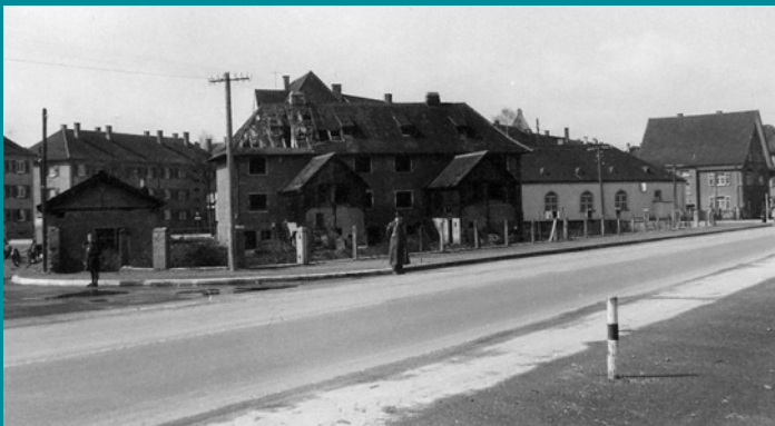
Bau der Kreistankstelle 1956
