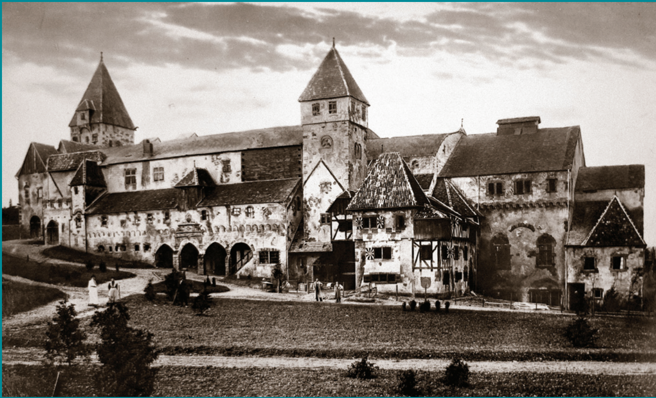
Festspielhalle, Singen, erbaut 1906, abgerissen 1918
