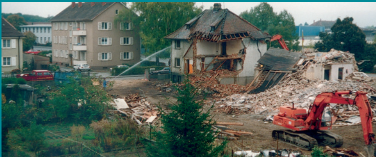
Wohnpark Aluminiumstraße, Sanierung 1985 – 1998
