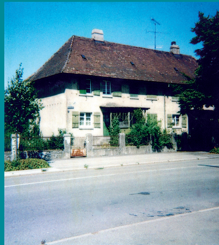
Bauvereinshäuser an der „Radolfzeller Straße“ Im „gefälligen Einfamilien-Reihenhaustyp“ wurden an der frühen Radolfzeller-, späteren Aluminiumstraße diese Häuser errichtet (Bild von 1982).
