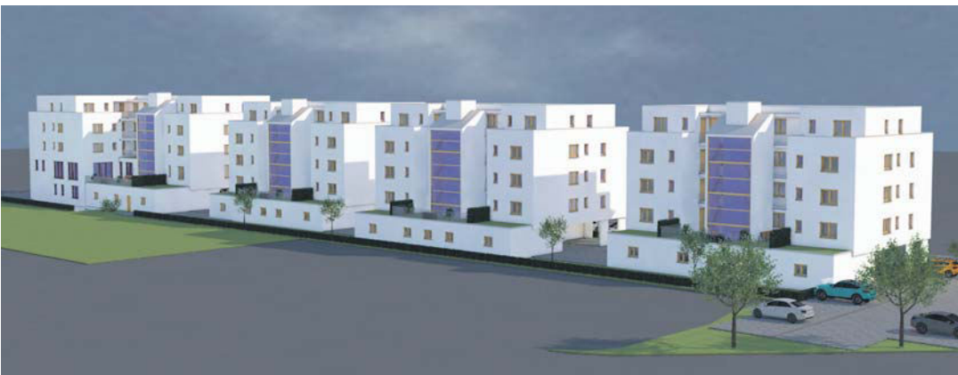
In der Karl-Schneider-Straße soll das nächste Bauprojekt der BGO starten.
