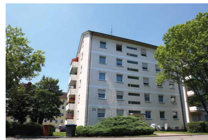
Konstanzer Straße 29 – Vor und nach der Sanierung
