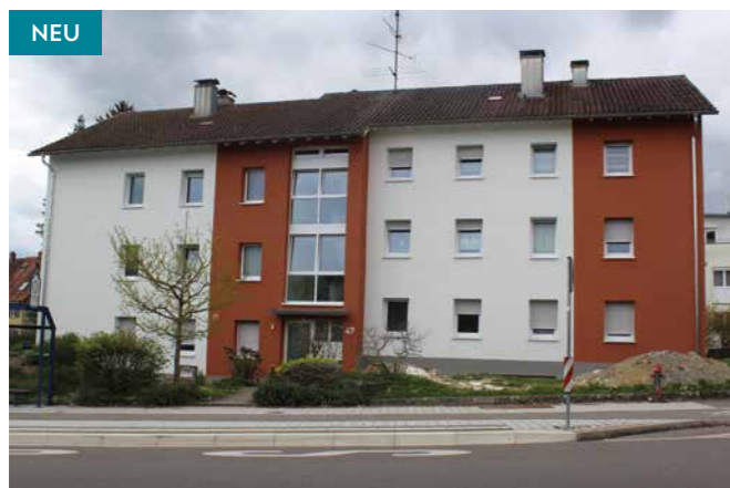
Anton-Bruckner-Str. 47 – Vor und nach der Sanierung
