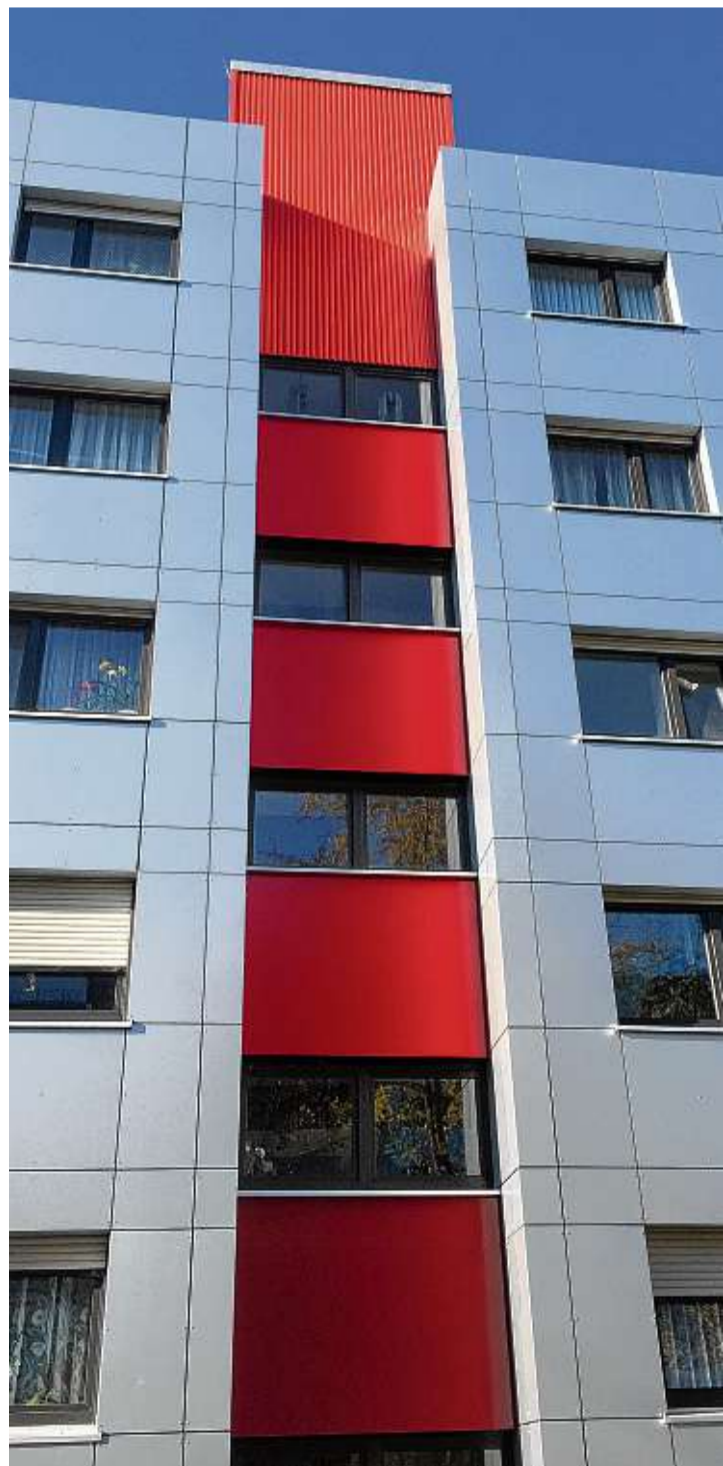
Ein Hingucker an dieser bereits fertigen Fassade ist der rote Mittelstreifen. Bis 2017 soll die Renovierung an allen Gebäuden abgeschlossen sein.
