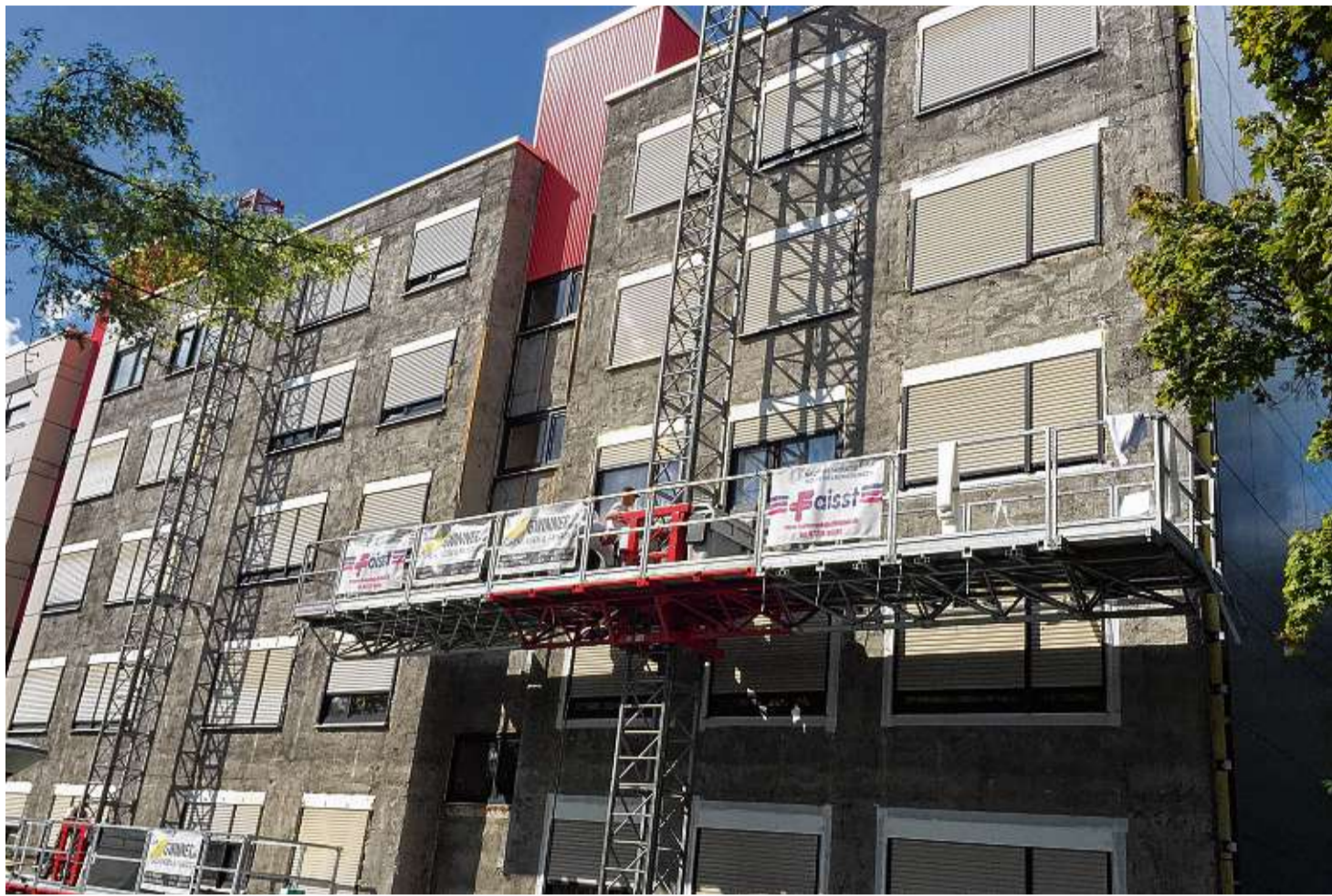
Die Sanierungsarbeiten in der Gartenstadt sind in vollem Gange. Die Baugenossenschaft Oberzellerhau hat sich bei den acht zu renovierenden Gebäuden für Aluminium an der Außenfassade entschieden. Im Einsatz sind spezielle Hebebühnen, die das Material sicher in die Höhe transportieren. BILDER: BGO
