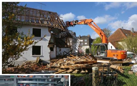
Nicht mehr zeitgemäß: Das alte Wohngebäude auf dem Gelände muss weichen
