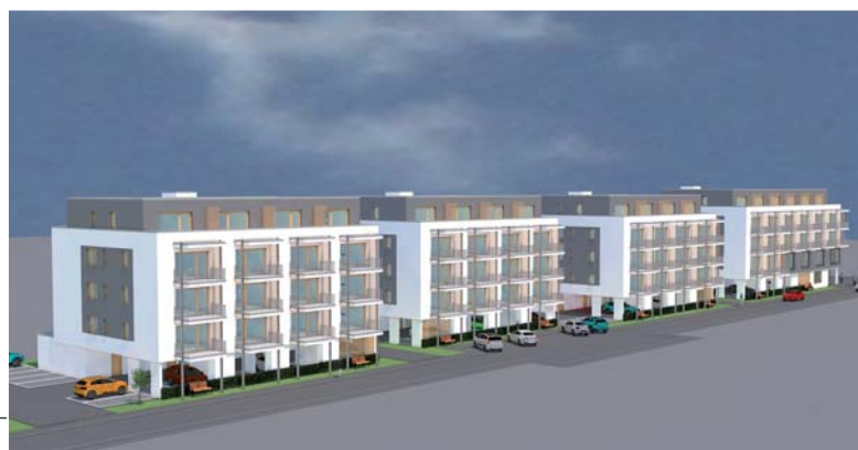
Westansicht des Bauvorhabens
